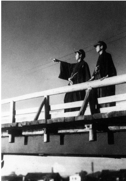
松江大橋の木製仮橋に佇む高校生
