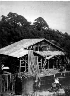
渡部家の家屋棟上げ後の撮影
