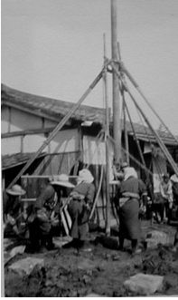
土台石の土木工事
